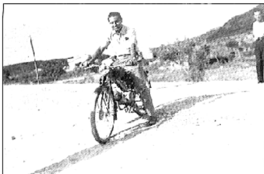
El primer vehicle a motor que va utilitzar per a desplaçar-se als masos
